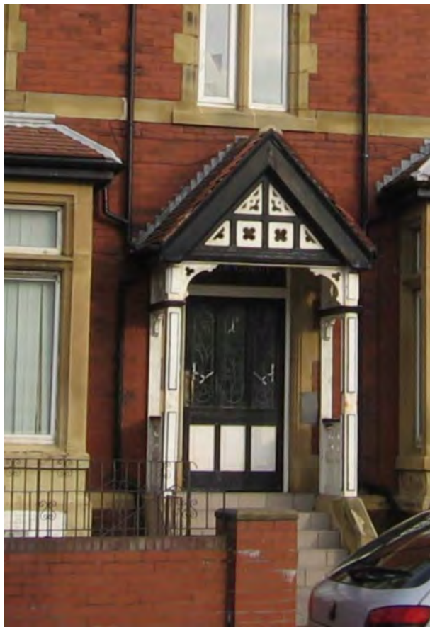
Fig. 37: Door canopy, No. 84 Park Road
