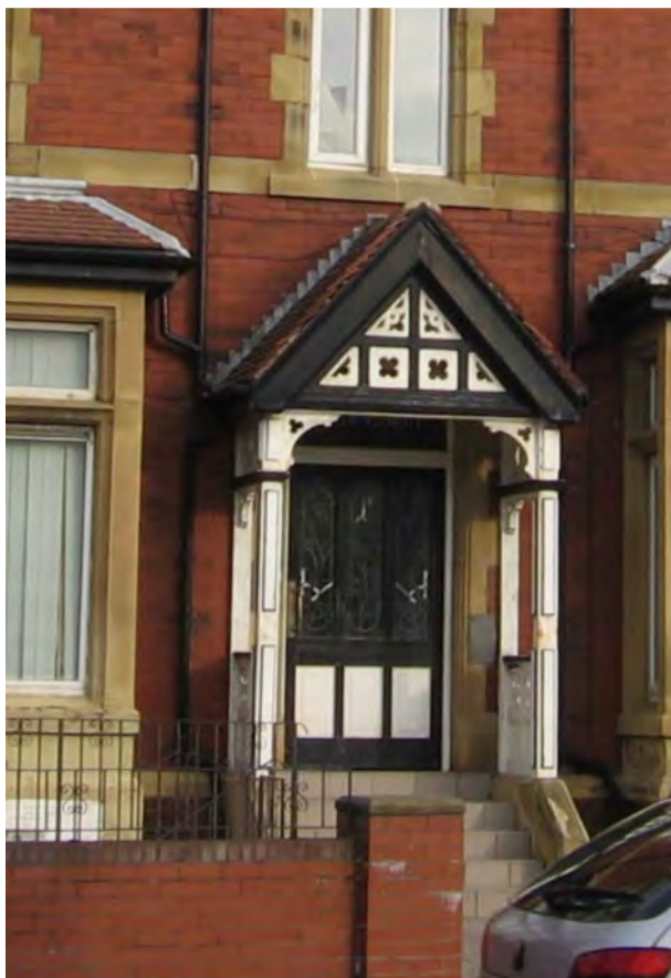
Fig. 37: Door canopy, No. 84 Park Road
